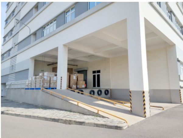
Khu vực bốc dỡ hàng - 裝卸貨區 - Container Loading Bay
